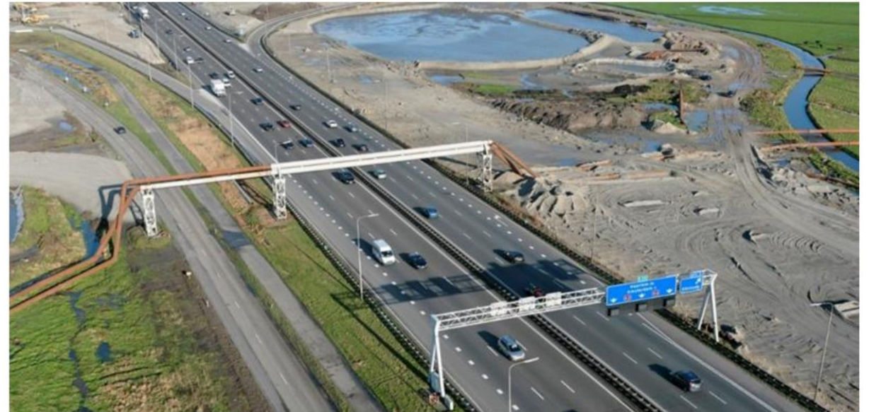
Exemple de traversée de route par pont tubulaire avec caisson
